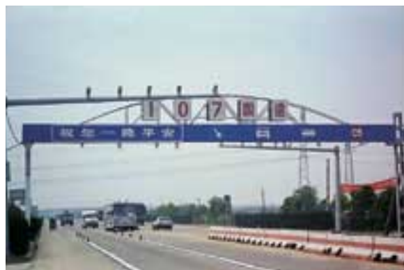
位於城市高速公路的記錄設備
