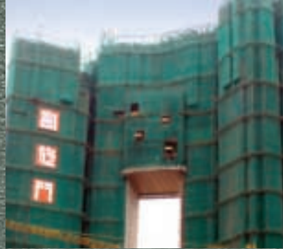
機場快線九龍站(第三期)凱旋門 Arc de Triomphe, Airport Express Kowloon Station (Phase 3)
