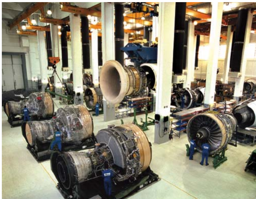
Engine testing facility at HAESL, Tseung Kwan O, Hong Kong 香港航空發動機維修服務公司於香港將軍澳的引擎測試設施。
