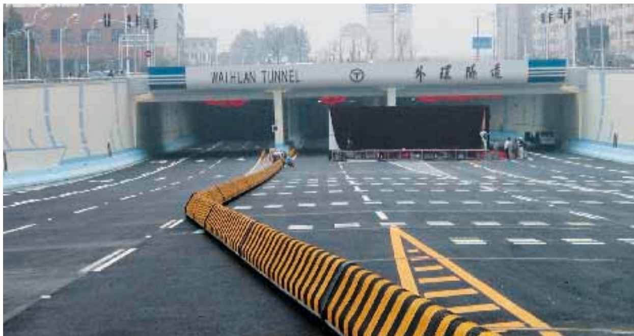
Tunnel Entrance 沉管入口
