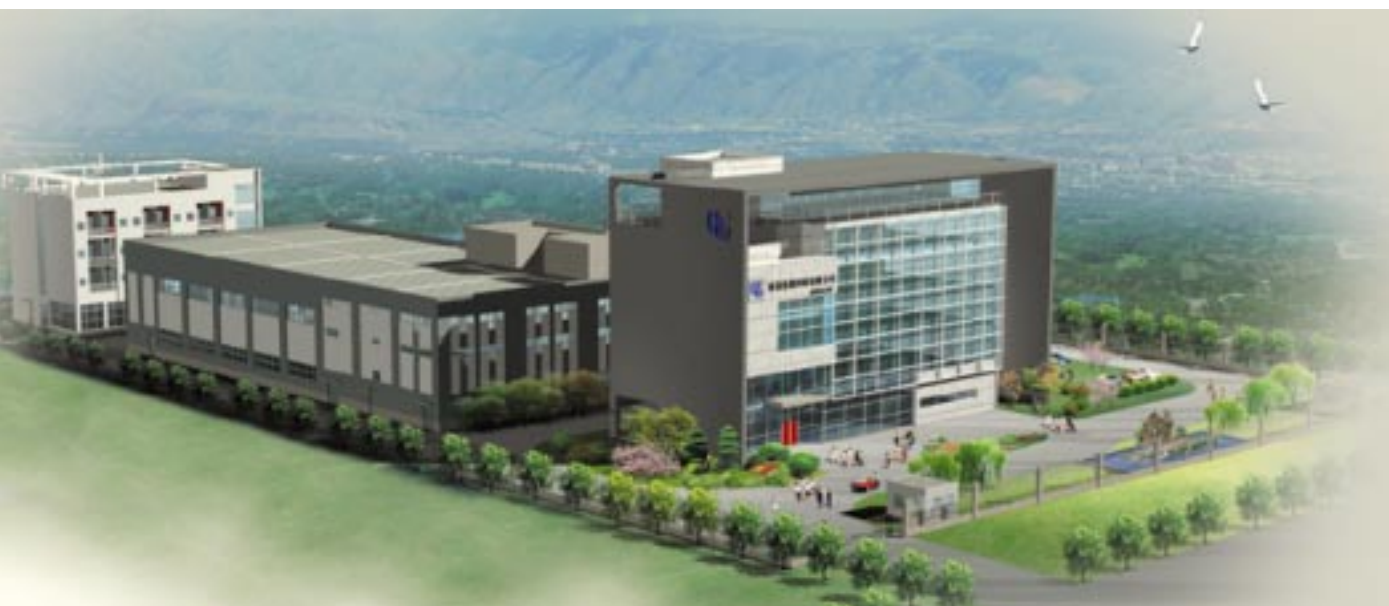
雲南僑通包裝印刷有限公司昆明分公司鳥瞰圖 Bird's eye view of Yunnan Qiaotong Package Printing Co., Ltd. Kunming Branch
