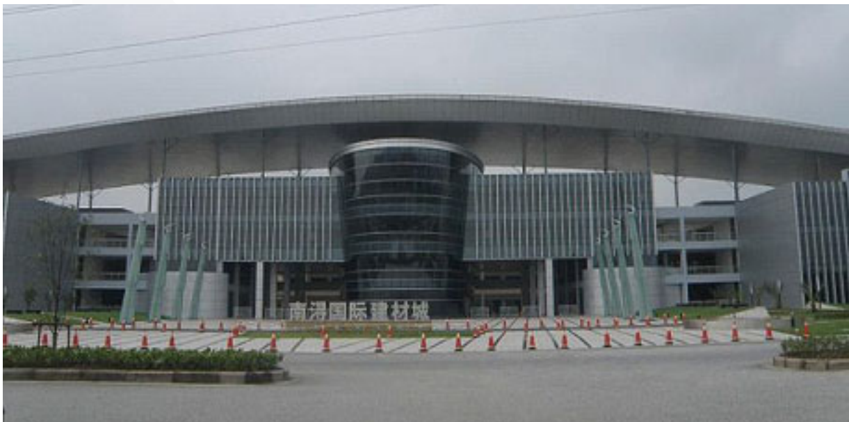
Nanxun Complex 南潯綜合大樓
