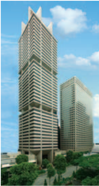
位於新加坡之星展大廈第一及第二座
