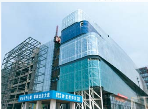
Trade center for machinery and hardware under construction ▼ 在建中的五金機電交易中心
