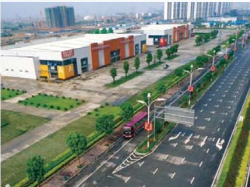
Logistics trade center under construction – Plaza 1 ▼ 在建中的物流交易中心—1號廣場
