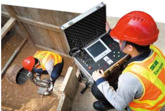
管內多功能工作機械人「Laparobot」是我們研發之創新工具，用以去除舊金屬管網中之吸水管，令管道修復過程更環保，成本效益更高。
