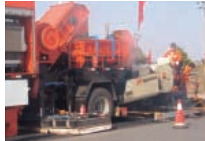
充分攪拌回收的混合料並採用熱粘結技術再加熱路面
