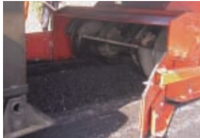
收集回收的混合料並輸送至拌拌機
