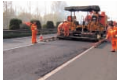
鋪設充分攪拌的回收混合料
