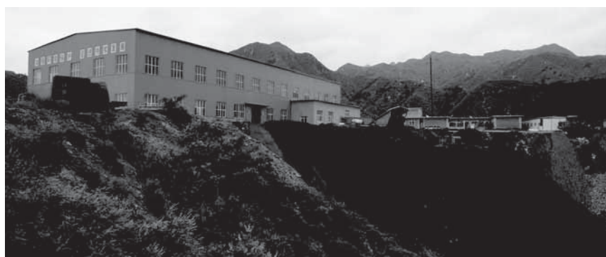
圖8-8：城子溝尾礦庫尾礦脫水車間和乾式排放
