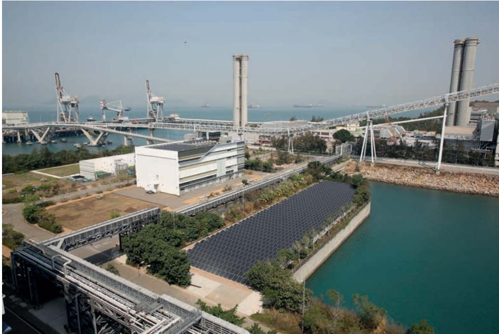
南丫擴建的薄膜光伏組件
