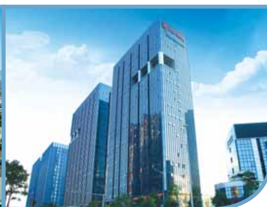
▲ International E-commerce logistics center in CSC Shenzhen 於深圳華南城的國際電商物流中心
