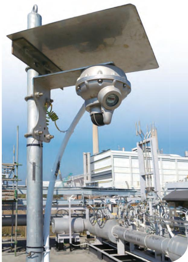
南丫發電廠安裝聲學感應器提升設施的安全度。
