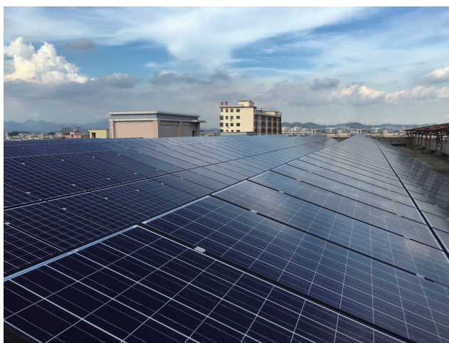
PV Project — the major thermal energy collector installation 光伏項目 — 主要熱能收集裝置
