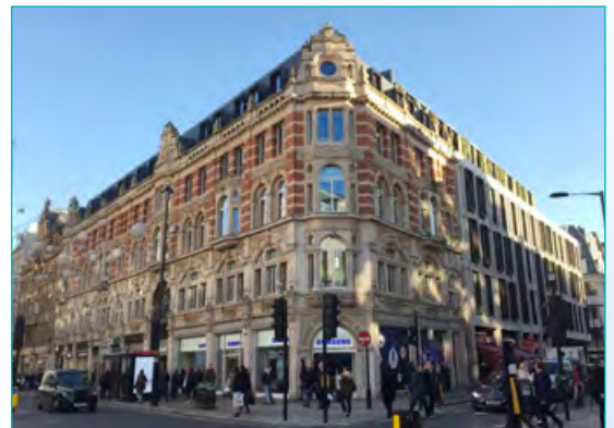
Ampersand Building, London 倫敦 Ampersand 大廈
