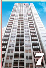
7 New Treasure Centre Property (portion) 新寶中心(部分)
