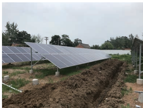
The 15MW Ye County Poverty Alleviation Project 葉縣 15MW 光伏扶貧項目
