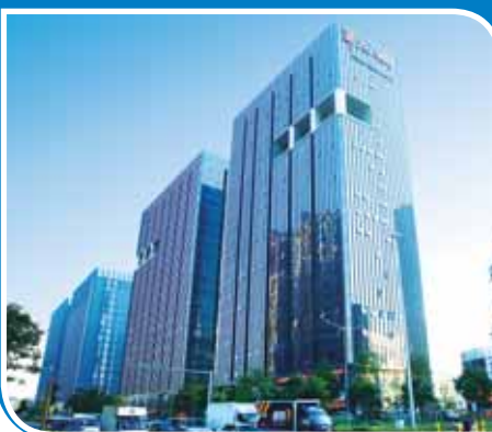
● International E-commerce Logistics Center in CSC Shenzhen 於深圳華南城的國際電商物流中心
