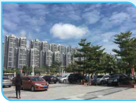
● Residential properties in CSC Nanning 於南寧華南城的住宅項目
