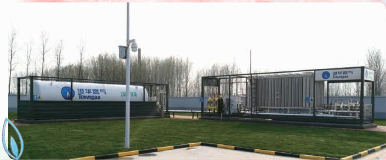
撬裝式小型液化天然氣過渡氣源站是工程部創新研究設計，並獲取國家1項發明專利及3項實用新型專利。
