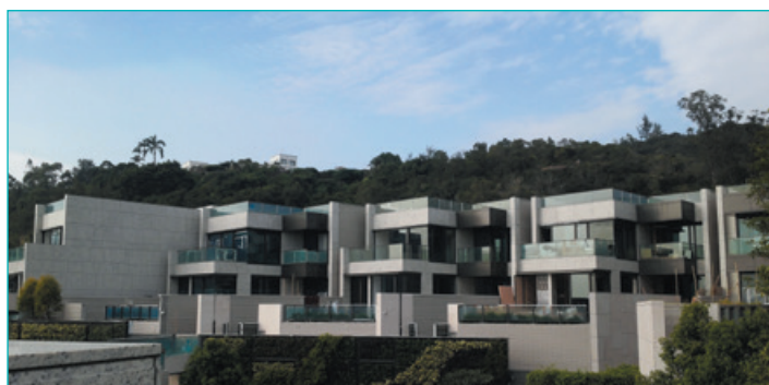
Residential project in Siu Lam 位於小欖之住宅項目
