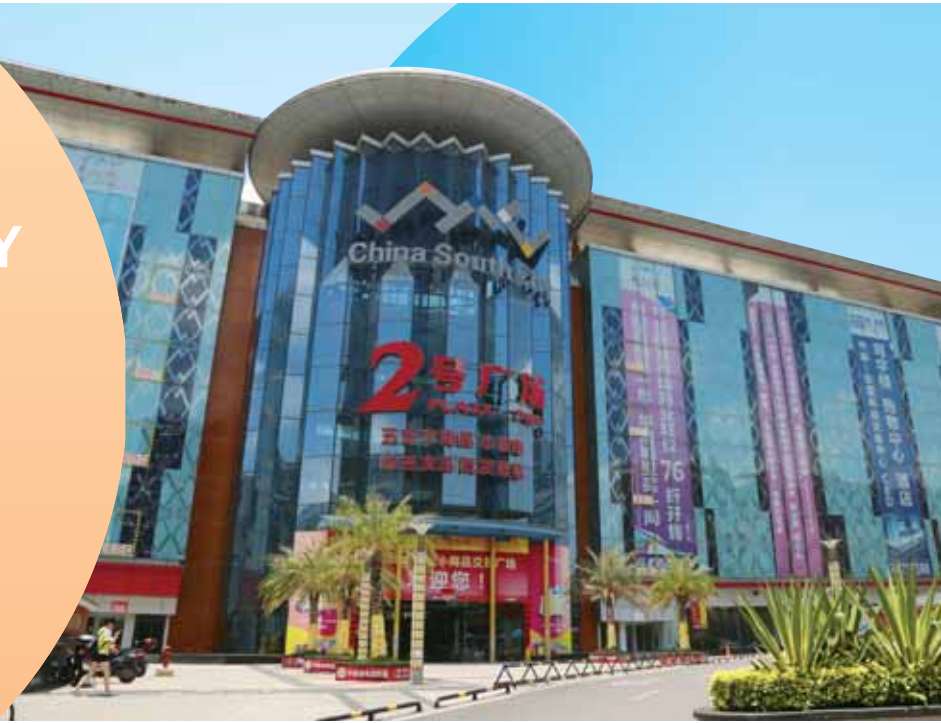
Plaza 2 in CSC Nanning 於南寧華南城的2號廣場
