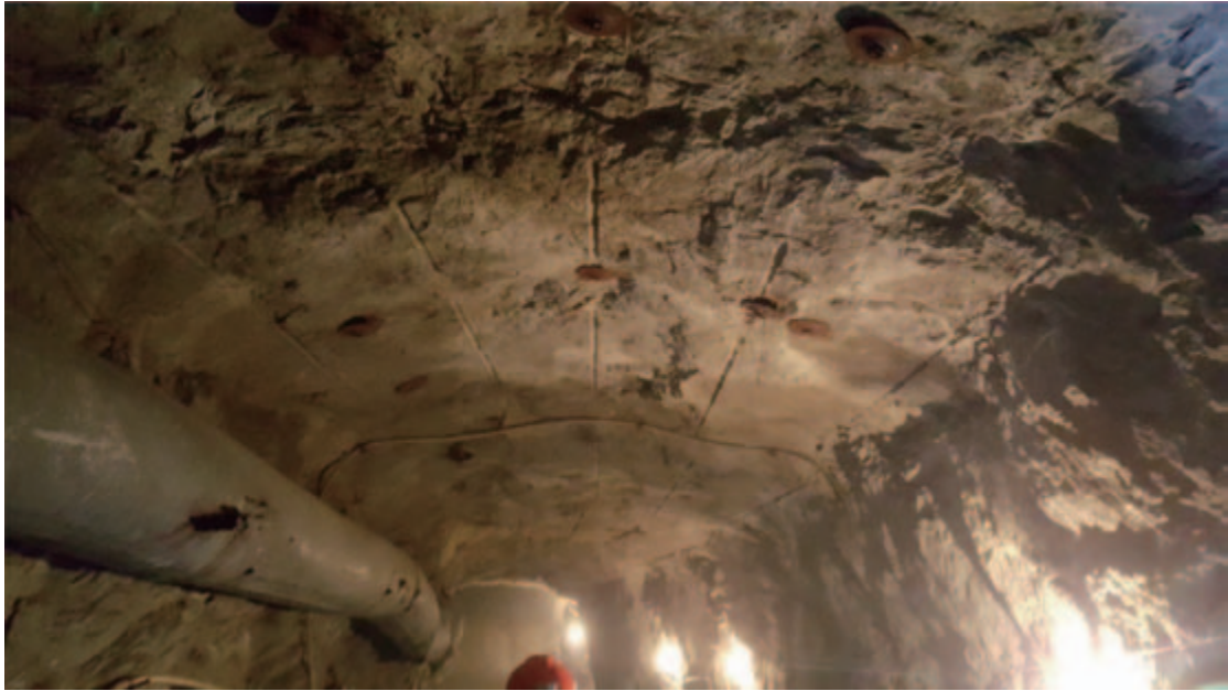
圖 16-3. 三山島和新立礦區主坡道支護
