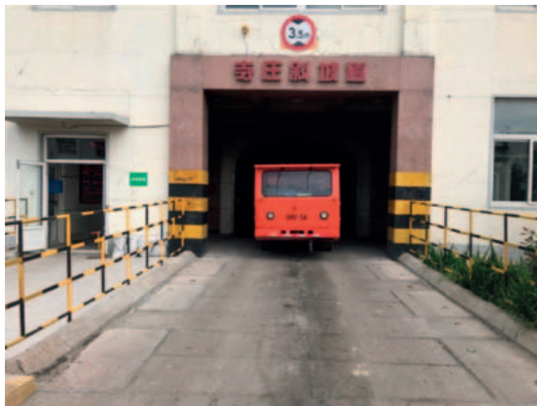
圖16-8. 寺莊礦區斜坡道入口
