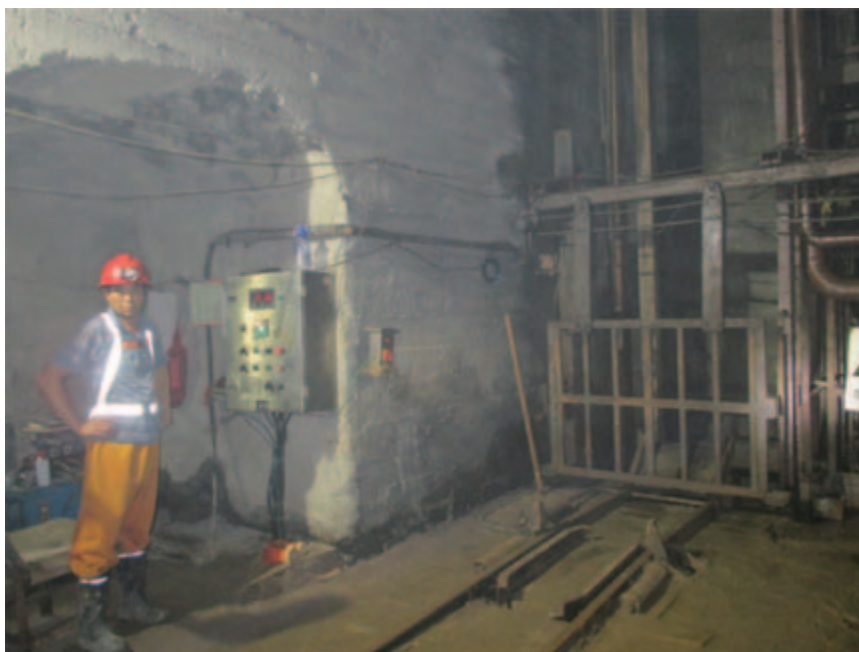
圖 12-7. 新城礦區 -380 中段豎井礦石提升站
