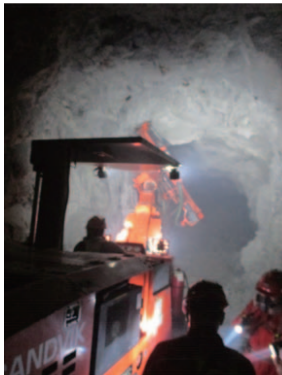
圖 12-6. 新城礦區井下 -510 中段石門裏面的錨杆鑽機
