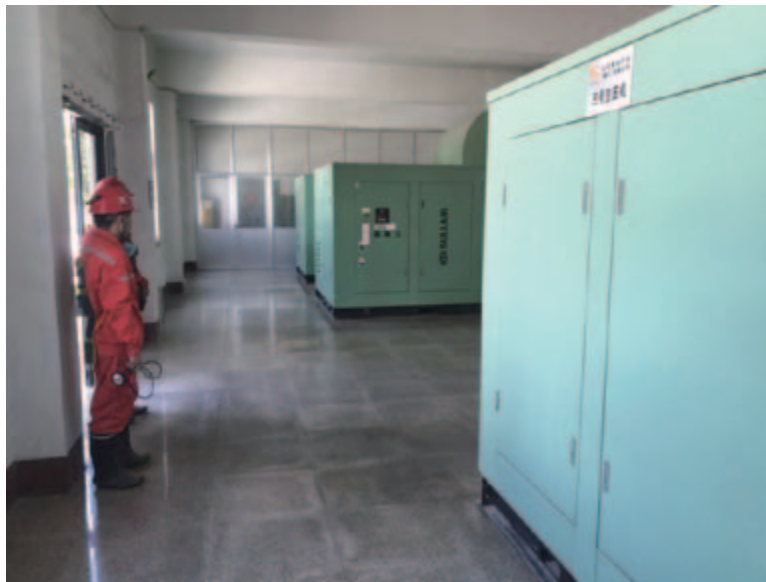
圖 16-4. 鑫匯金礦壓縮機房
