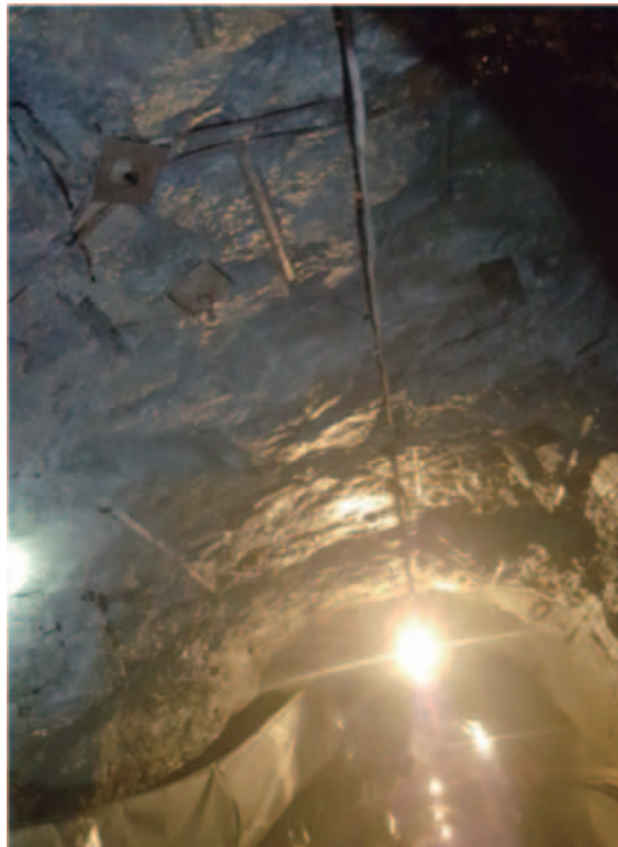
圖 16-3. 歸來莊金礦主斜坡道支護
