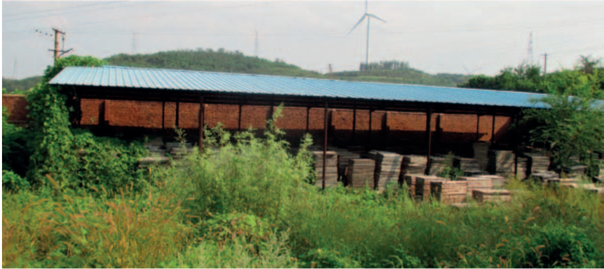
圖 10-1. 蓬萊礦業公司岩芯庫，有覆蓋的岩芯庫
