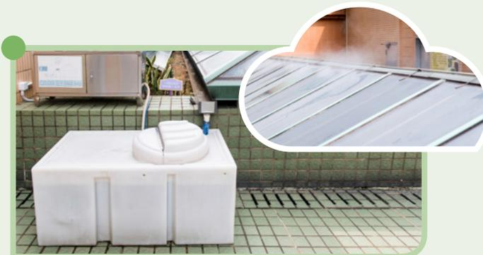
※ 愛琴海岸研發太陽能雨水收集霧化系統，將雨水霧化並噴灑於天幕玻璃，令玻璃表面降溫，從而降低室內溫度
