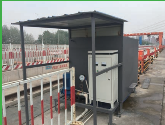
圖：施工現場的變頻增壓泵
