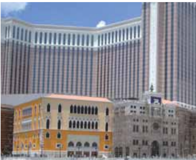
▲ 澳門威尼斯人渡假村 - 棚架及玻璃纖維強化水泥工程 Venetian Macau Scaffolding and GRC Works
