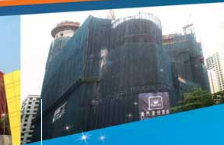
澳門皇冠酒店 - 棚架工程 Crown Macau - Scaffolding Works
