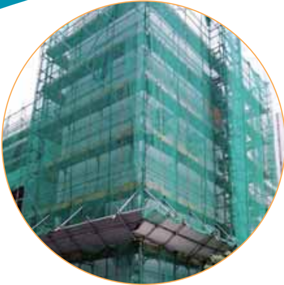
▲ 圓洲角中車站 - H架鐵棚工程 Yuen Chau Kok CLP STATION H Frame Scaffold
