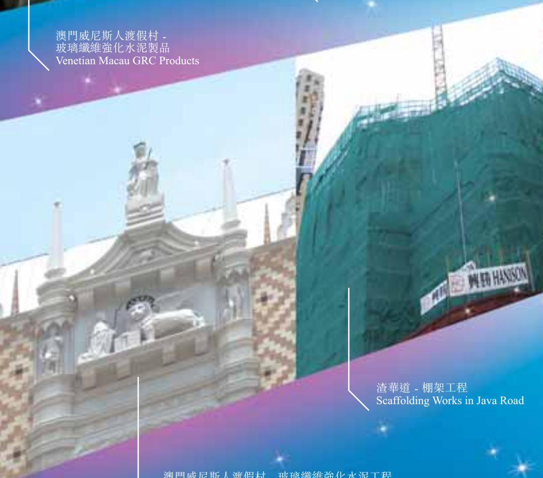
澳門威尼斯人渡假村 - 玻璃纖維強化水泥工程 Venetian Macau GRC Works
