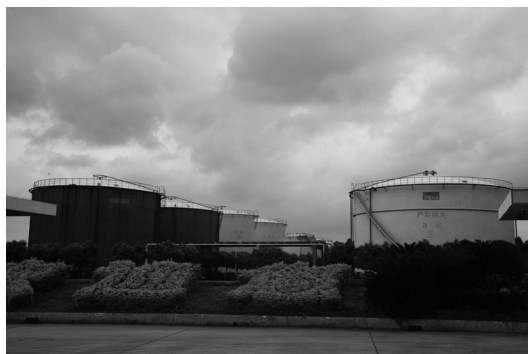
圖8：樵江油庫油罐
