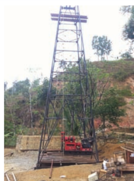
Drilling work in Indonesia 印尼鑽探工作
