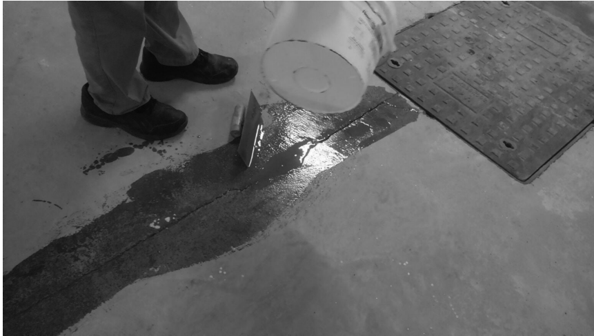
(iii) 地面整修－修復地面裂縫
