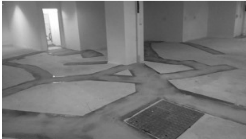
(iv) 地面整修－底層缺陷修補工程
