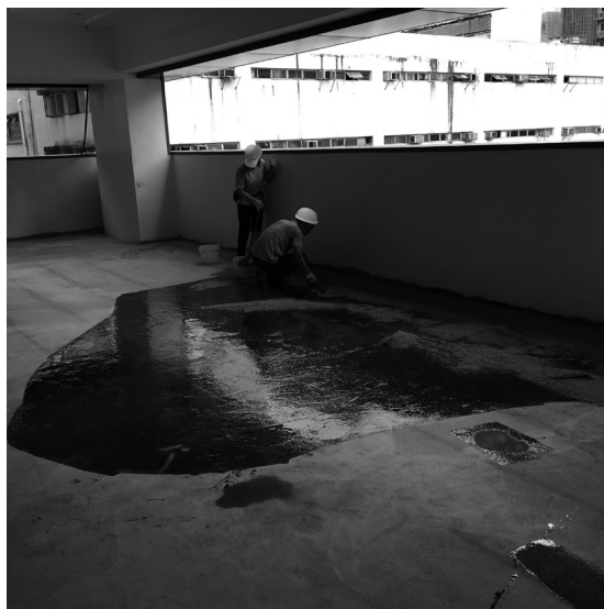
(iv) 地面整修－底層缺陷修補工程
