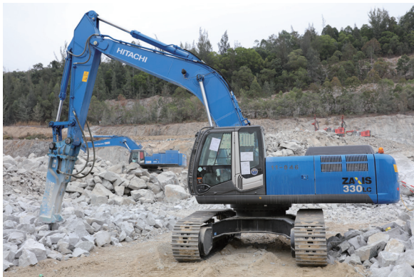
具液壓破碎機的挖土機
