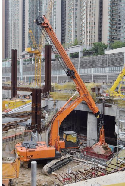
具30米伸縮臂泥夾斗及滑動駕駛倉的挖土機
