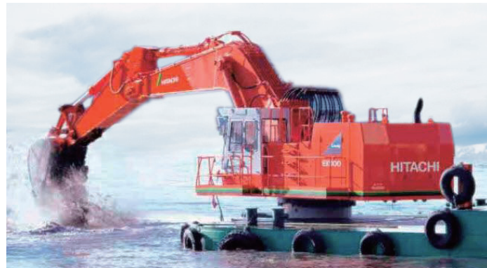
180噸級海上挖土機
