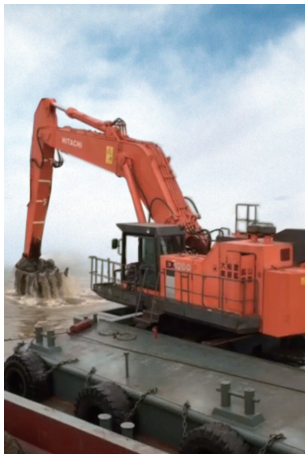
120噸級疏浚挖土機
