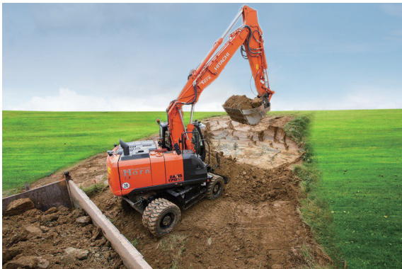
輪動式挖土機
