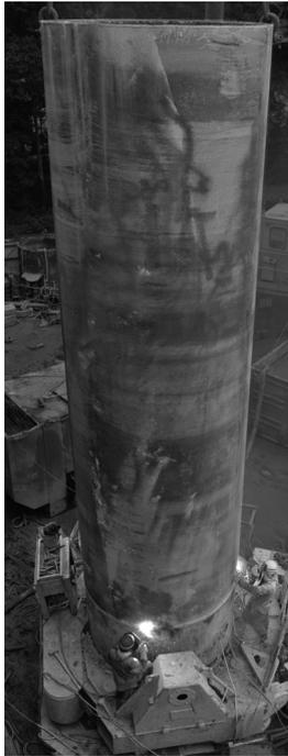
將打入地層的臨時鋼套管
