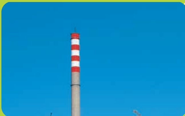
Tuoketuo Power Plant Phase I
