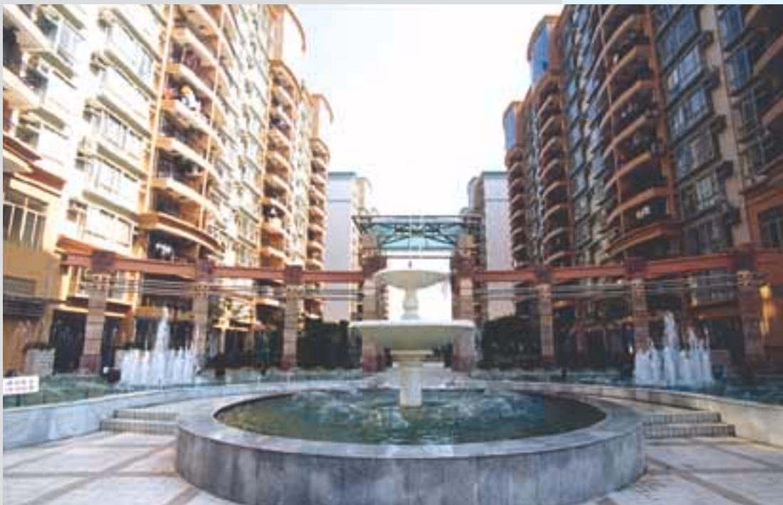
Recreation Area of Gallopade Park 駿景花園休憩小區
