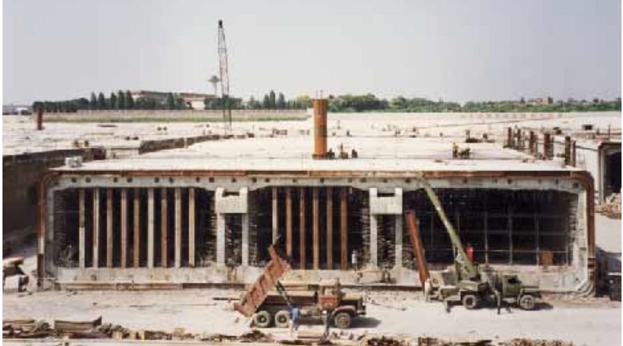
Fabrication of Tunnel Element 建設中的沉埋管
