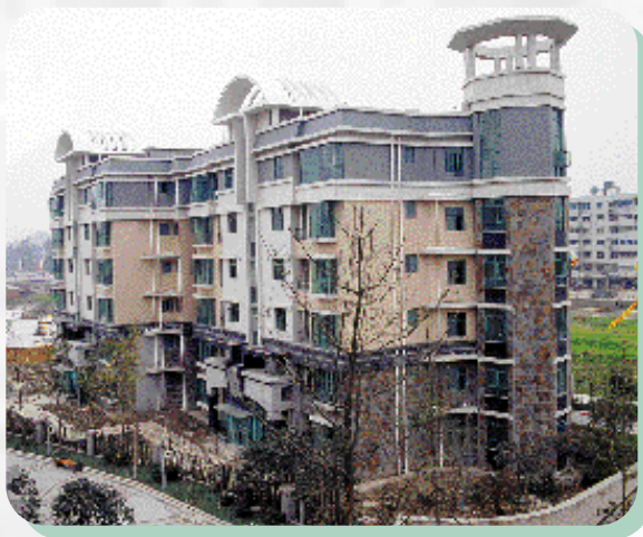
Grandeur Vista, Chengdu
