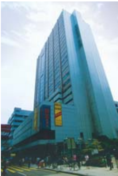
栢裕商業中心 Park-In Commercial Centre
