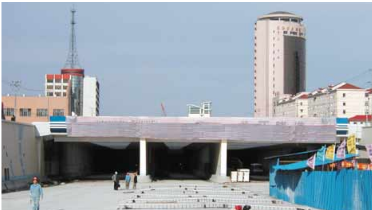
Tunnel Entrance 沉管入口
