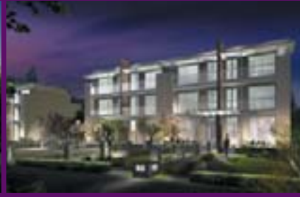
Zhangjiang Tomson Garden Phase 1 (Villas) 張江湯臣家園一期(別墅)
