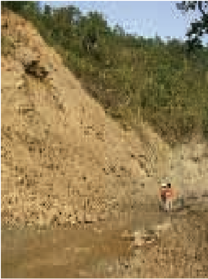
圖5-14：往炭濾法儲存設施通道的近期故障，二零零六年十月十五日
