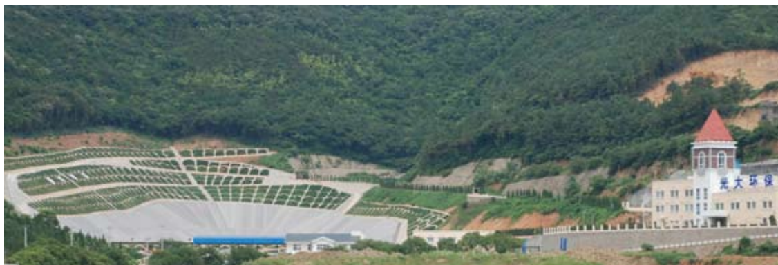
Industrial Solid waste landfill 工業固體廢物安全填埋場
