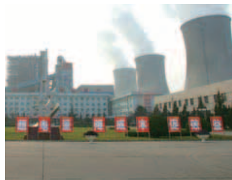
Infrastructure – Shaanxi Weihe Power Co., Ltd
