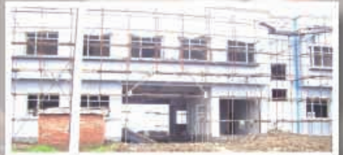
C8-Temporary Office 臨時辦公室
