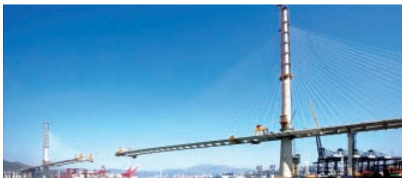
The Stonecutters Bridge project 昂船洲大橋項目
