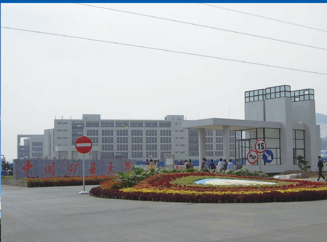
中國礦業大學項目 China University of Mining and Technology Project
