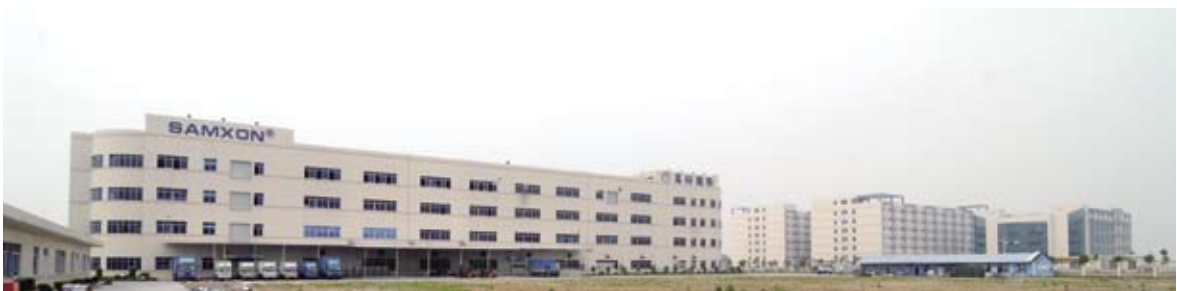
本集團位於中國東莞市長安鎮之電解電容器生產廠房背面圖
